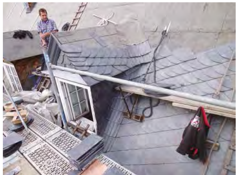
■ Eine besondere Herausforderung: die 80 Dachgauben.
